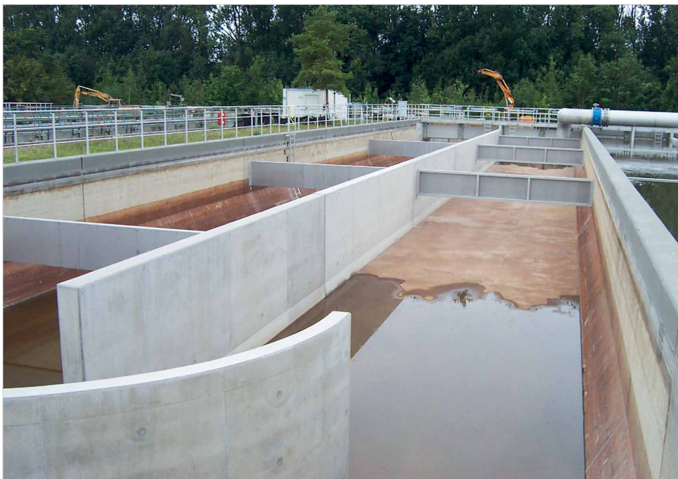
Trennwände, Leitwände und Tauchwände (Becken entleert)
