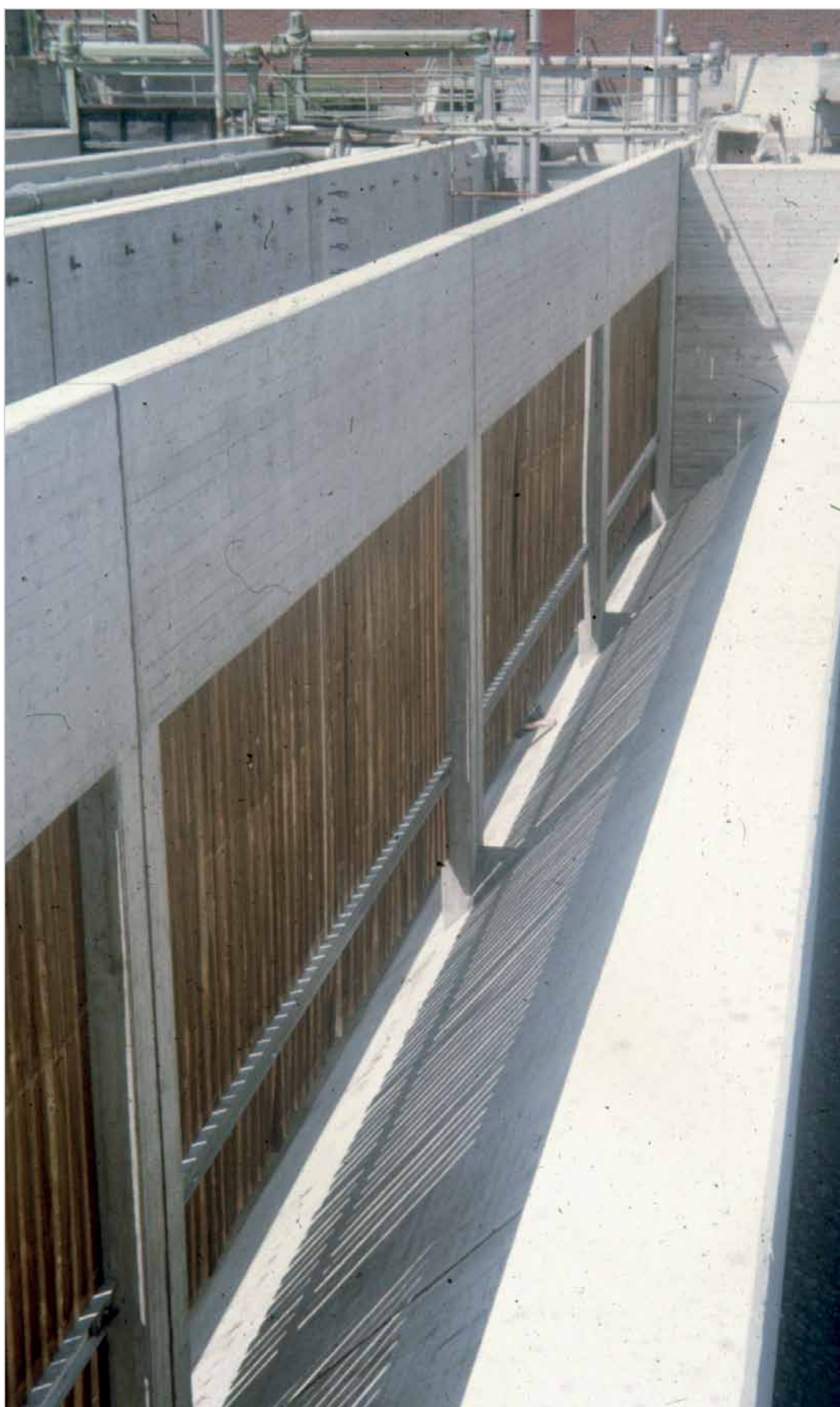
Leichtstoffabscheider (entleert)
