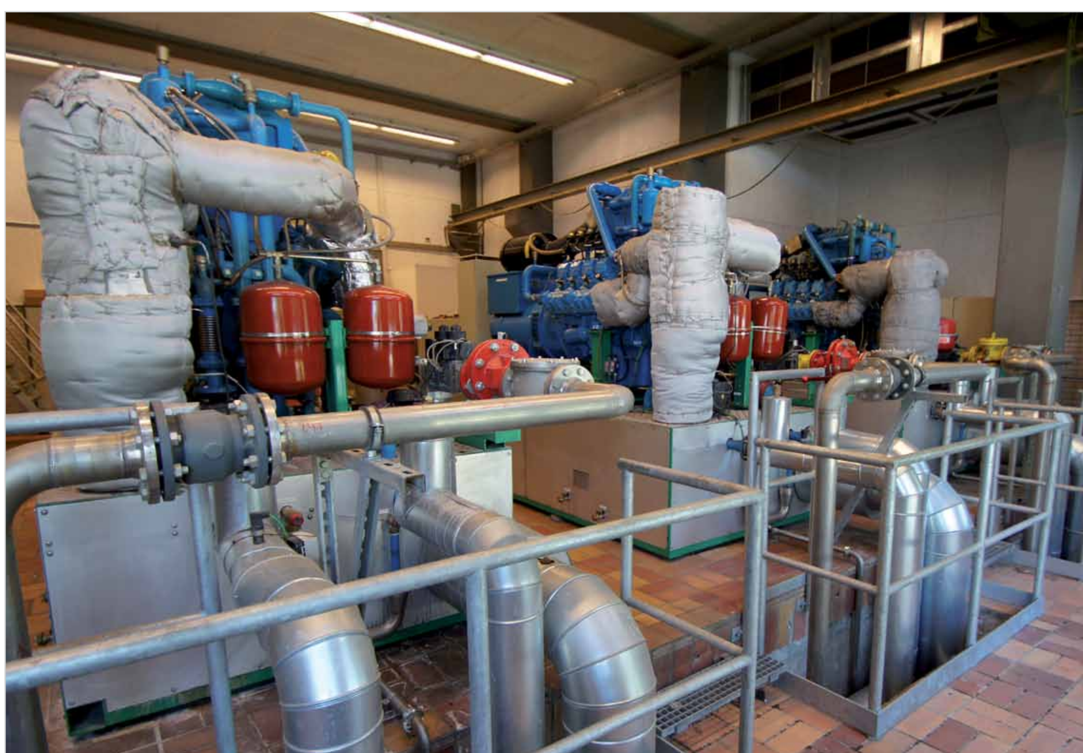
Blockheizkraftwerke
